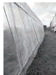
巻き上げパイプ取り付け
