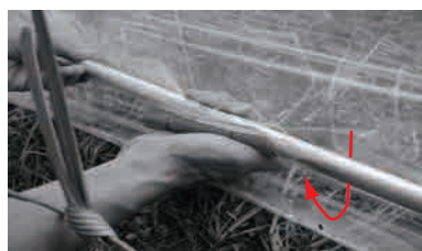
ビニールを外側より、巻きつけてパッカーを取りつける。
