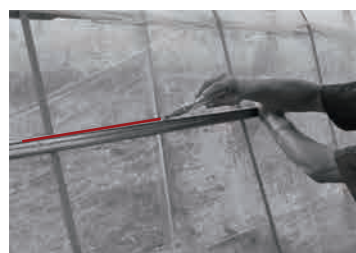
枠取りの線引き時に、ビニバーを利用すると、書きやすいです。
