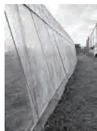
巻き上げパイプ取り付け
