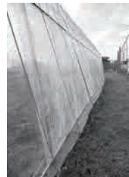
巻き上げパイプ取り付け
